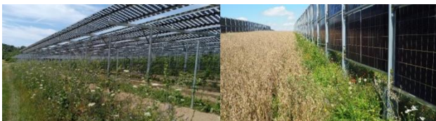
Abbildung 1: links: Hochaufgeständerte APV-Anlage über Wein in Freiburg. Rechts: Vertikale, bodennahe APV-Anlage mit einem mehrjährigen Blühstreifen unter den Modulen in Merzig.
